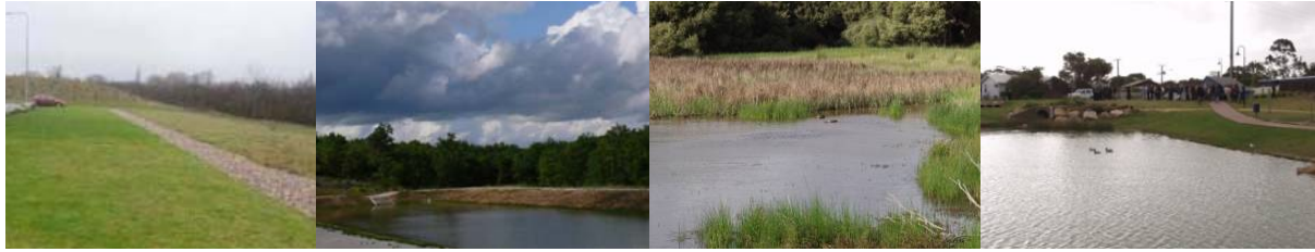
Figura 8 Franjas Filtrantes, Depósitos de detención, Estanques de retención y Humedales artificiales.
